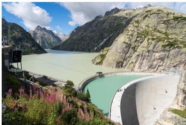
Alte und neue Staumauer am Grimselsee*
